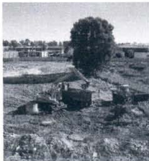
Las obras ya se han iniciado. · Autor: Información
