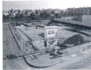
Las obras están en marcha. · Autor: Información
