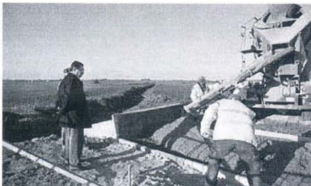
El edil del ramo, Antonio Peña, supervisó las obras.
