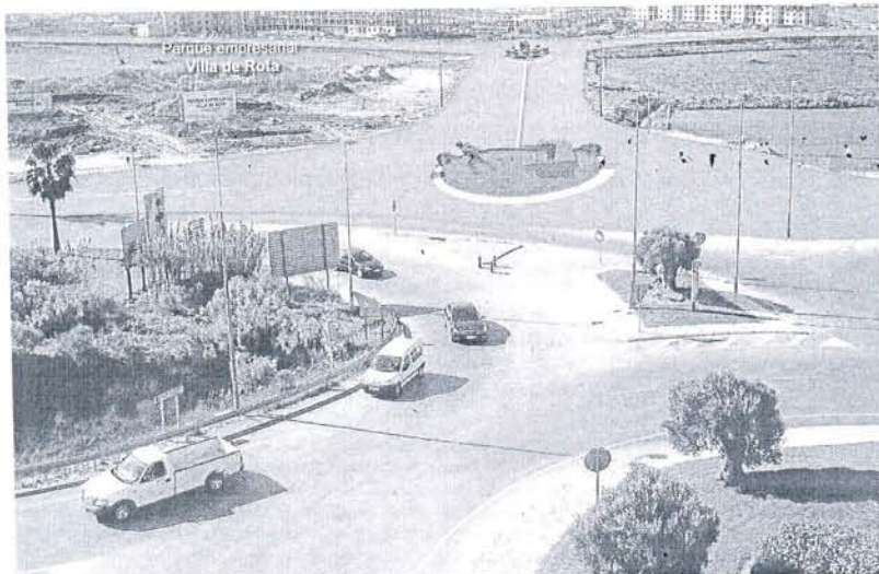
Un fotomontaje del Ayuntamiento que muestra el aspecto que presentará el acceso cuando acaben las obras.
