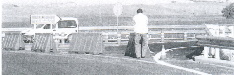
Un operario trabaja en los últimos detalles de la variante.
