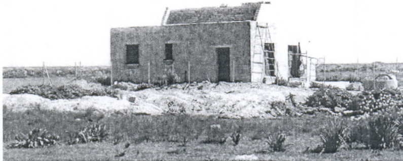
Una de las construcciones que se levantan sobre una cañada en el término municipal portuense.
