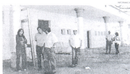
El edificio se encuentra en un estado de construcción bastante avanzado.
