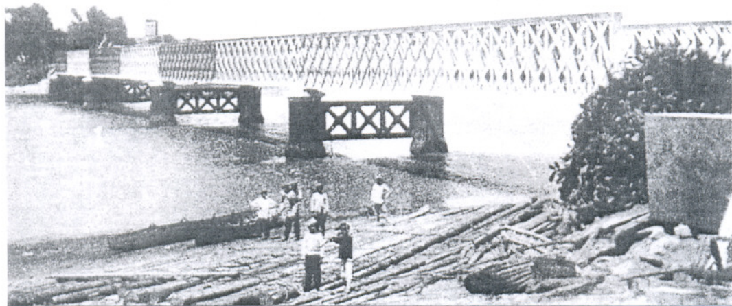
Reproducción de una antigua imagen del puente San Alejandro, que se reutilizará para dotar de un nuevo acceso al parque metropolitano.
