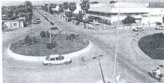
PROBLEMA. El polígono sufre anegaciones cuando llueve sobre la localidad. /LA VOZ
