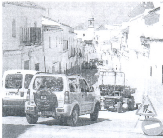
Las obras ya han comenzado en la calle San Sebastián.
