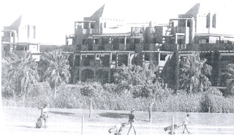
La Junta de Andalucía ya ha iniciado las obras de instalación de otro tubo en el complejo residencial / P.A.
