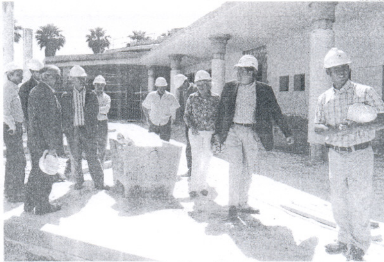
El alcalde de Rota visitaba recientemente las obras de la estación intermodal para comprobar su avance.
