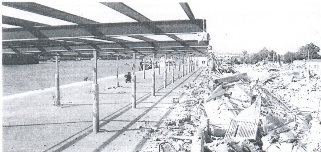
Las instalaciones de la vieja lonja de la margen izquierda del río ya están demolidas y en los próximos días se procederá a la retirada de escombros. ANDRÉS MORA
