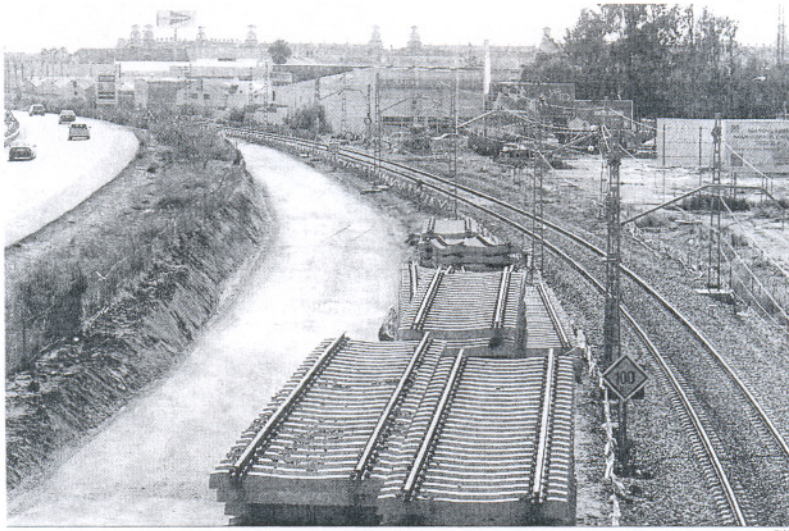
Imagen de las obras de desdoble de la vía para la Alta Velocidad en San Fernando, a principios de este verano.
