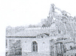
Un momento del derribo.
