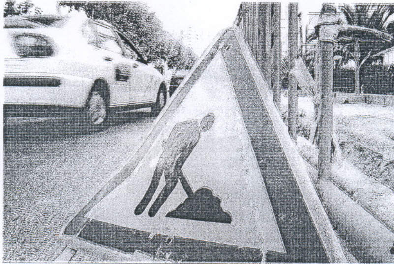
Obras en una calle de Málaga.
