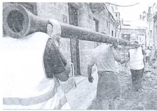
Varios de los obreros que trabajan en esta obra.
