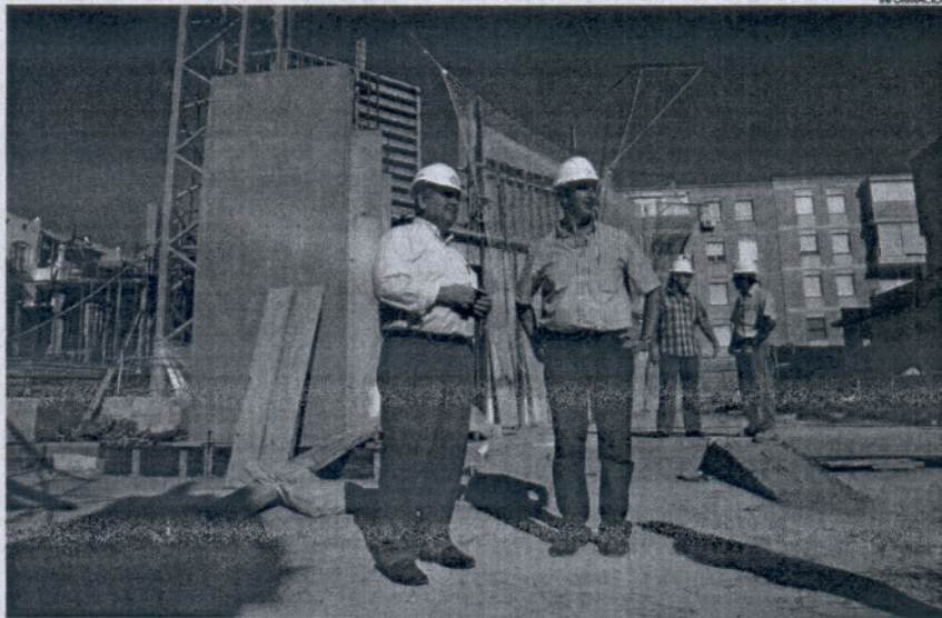
Las obras estarán finalizadas mucho antes de lo que se había previsto, para la primavera de 2010.
