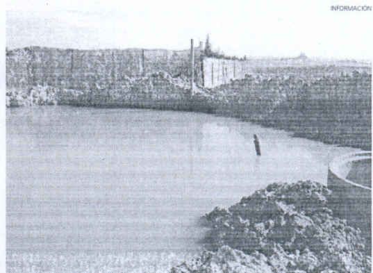
La zona de la Colada del Galgo tiene este aspecto debido a la avería.
