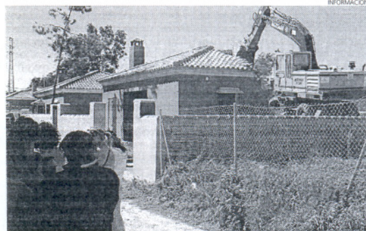
El fiscal de Medio Ambiente aboga por las demoliciones.
