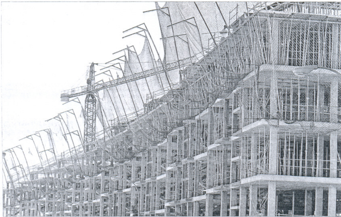
Construcción de un bloque de viviendas en Dos Hermanas (Sevilla). / GARCÍA CORDERO
