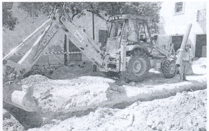
OBRAS EN LA PLAZA SAN MARCOS
