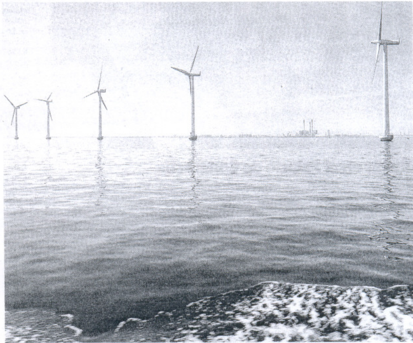
Una vista parcial del parque eólico marino de Middelgrunden, en aguas de Copenhague, en Dinamarca. SIEMENS/AG
