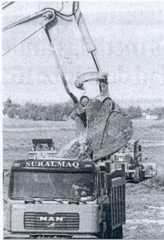
Día del inicio de las obras en el polígono.
