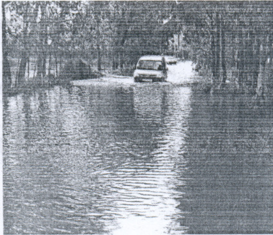
PUERTO REAL. El acceso al cementerio se inundó ayer. / T. B.
