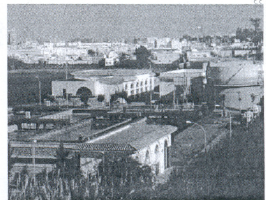
La depuradora de Sanlúcar está ubicada en una zona en expansión.
