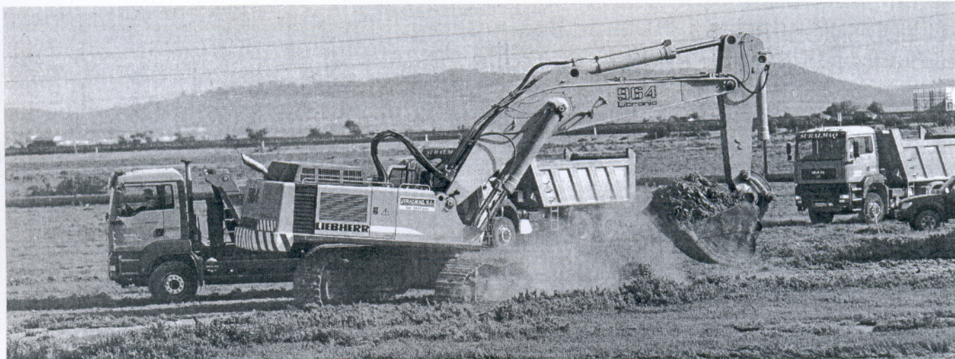
Ayer entraron los primeros camiones de los 15.000 que serán necesarios para realizar los rellenos previstos.
