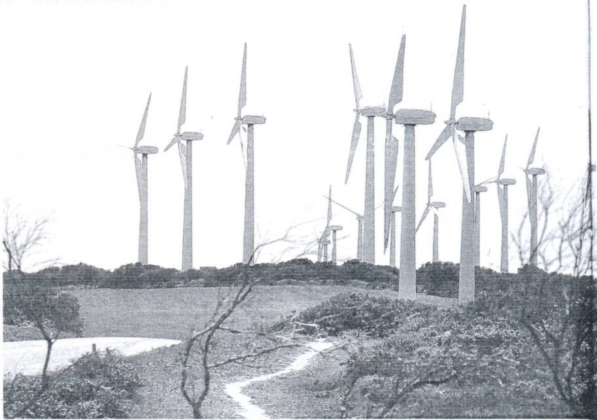
Andalucía ha perdido competitividad en instalación de parques eólicos, donde hasta hace pocos años mantenía el liderazgo
