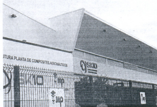
ALESTIS. Planta de composites construida en TecnoBahía. / R. RÍOS
