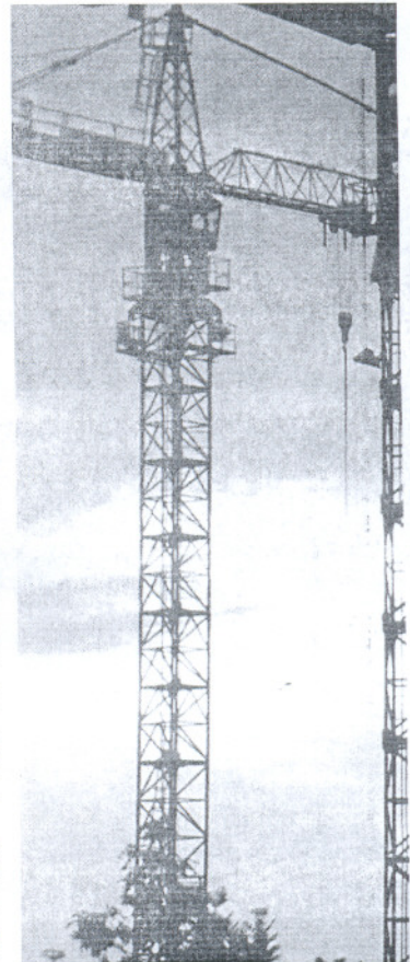
Dos operarios contemplan grúas destinadas a la co
