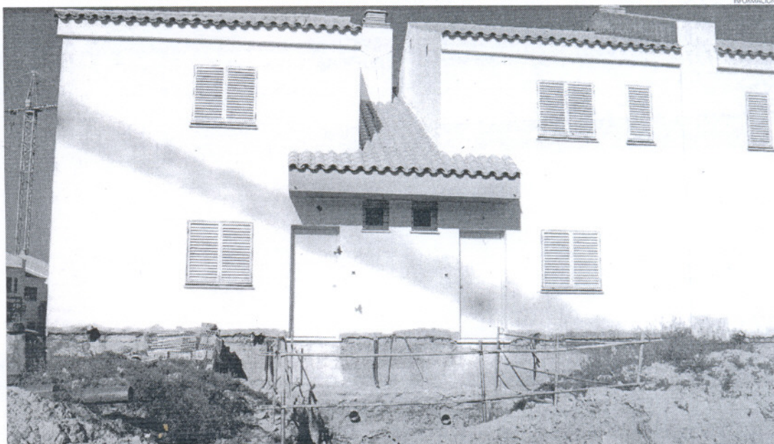
Una promoción de viviendas de protección oficial en plena construcción que se está llevando a cabo en la localidad sevillana de Espartinas.
