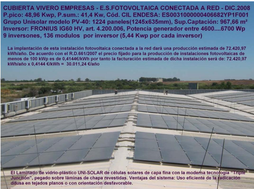
El Laminado de vidrio-plástico UNI-SOLAR de células solares de capa fina con la moderna tecnología "Triple Juncción", pegado sobre láminas de chapa revestidas. Ventajas del sistema: Uso eficiente de la radiación difusa en tejados planos o con orientación desfavorable.
