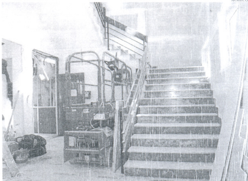
Aremsa ejecuta las obras en la planta baja de las dependencias municipales de plaza España.
