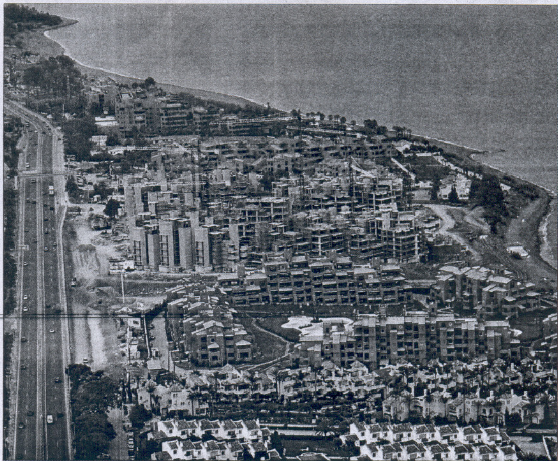
Vista aérea de edificaciones en la costa de Estepona (Málaga). / JULIÁN ROJAS
