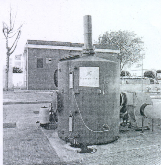
Instalación de un sistema de desodorización de Konectia en Rota.
