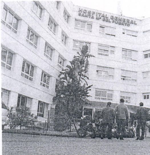
Fachada del hospital de Pascual en El Puerto.
