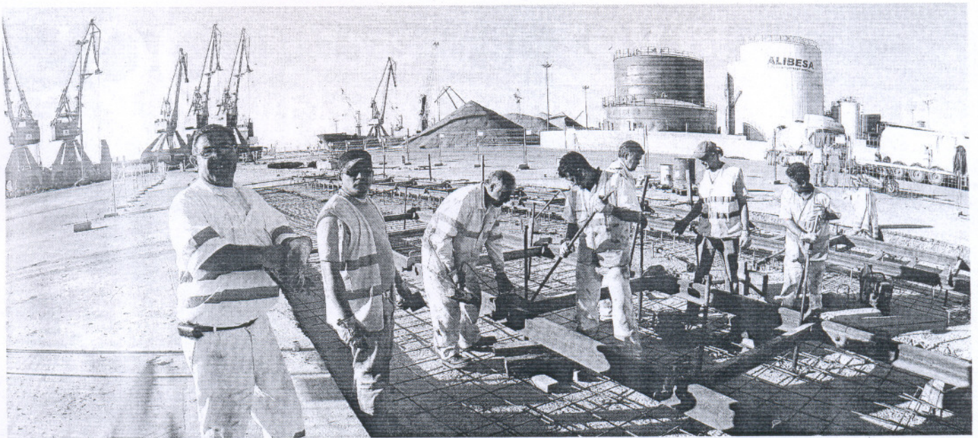
TRABAJOS. Un grupo de operarios trabaja en el tendido ferroviario en La Cabezuela en las inmediaciones de Navantia. / ANTONIO VÁZQUEZ
