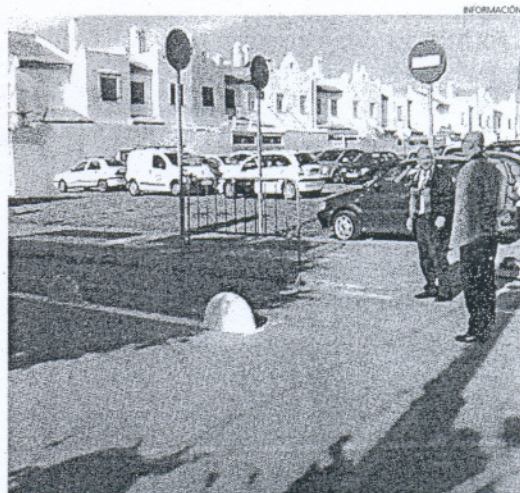
Los delegados municipales comprobaron el estado avanzado de las obras.
