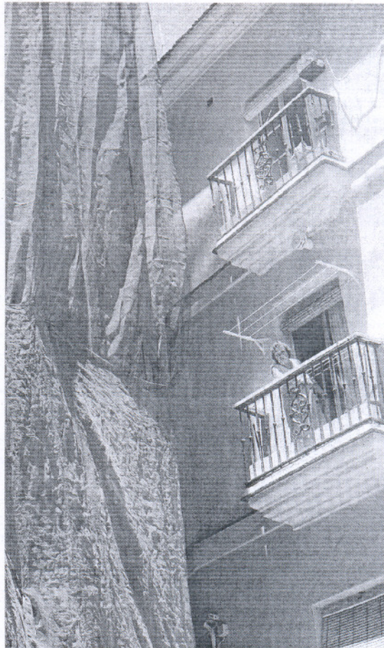
A LA ESPERA. Imagen de una fachada en obras en Cádiz. / F. J.
