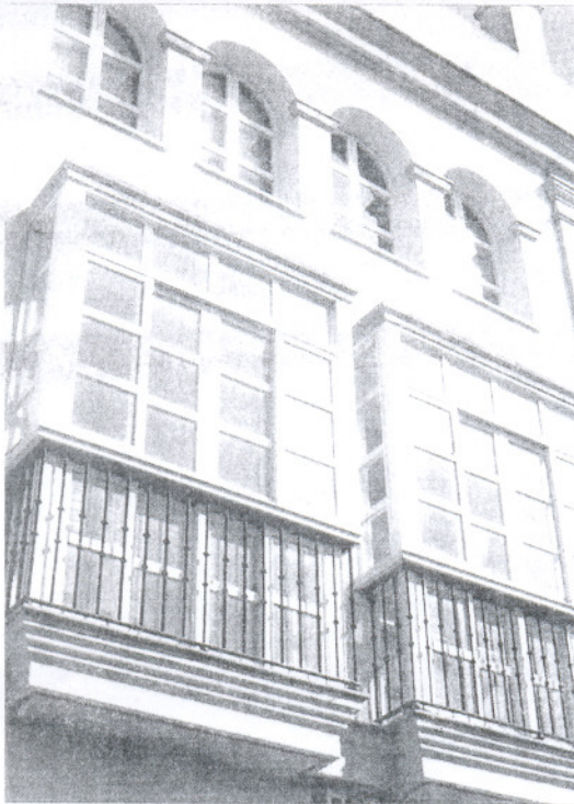
Edificio de El Puerto en el que los acusados tenían una oficina.
