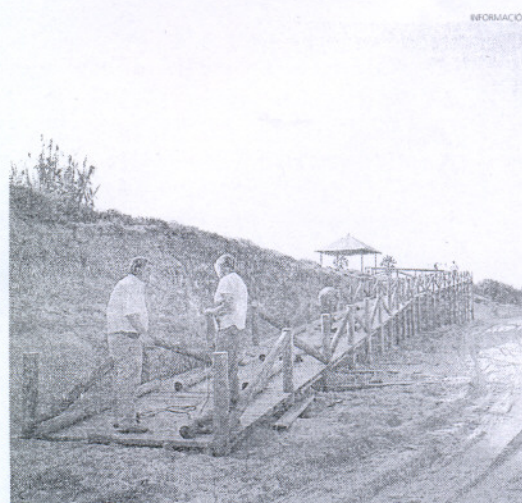
Esta pasarela se suma a las ya instaladas a lo largo del litoral roteaño.
