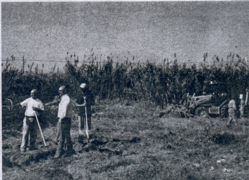
Los trabajos del vallado perimetral de la zona desde El Picadero a Punta Candor ya han comenzado.
