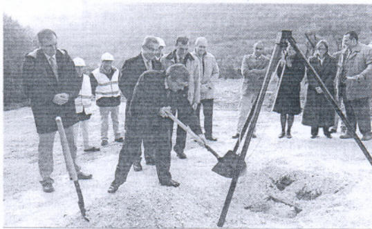
El consejero colocó la primera piedra en las obras de Alcalá.
