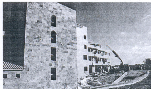
Imagen de archivo del Hotel Elba durante su construcción. /LV
