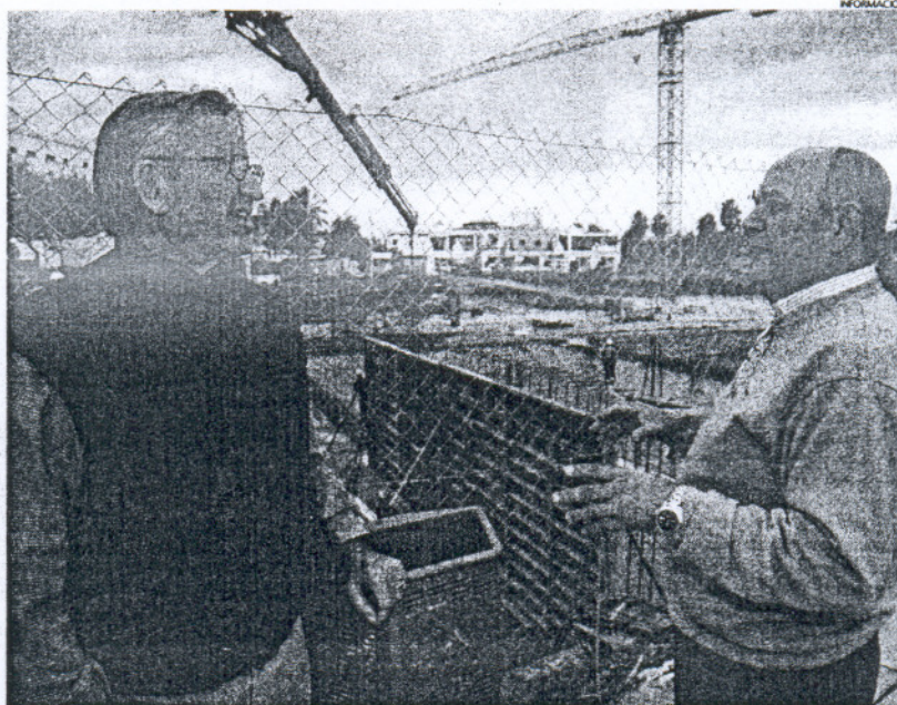
Estas obras supondrán una importante implementación de dotaciones necesarias para el complejo turístico.
