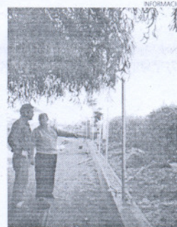
Jesús Corrales visitó las obras.
