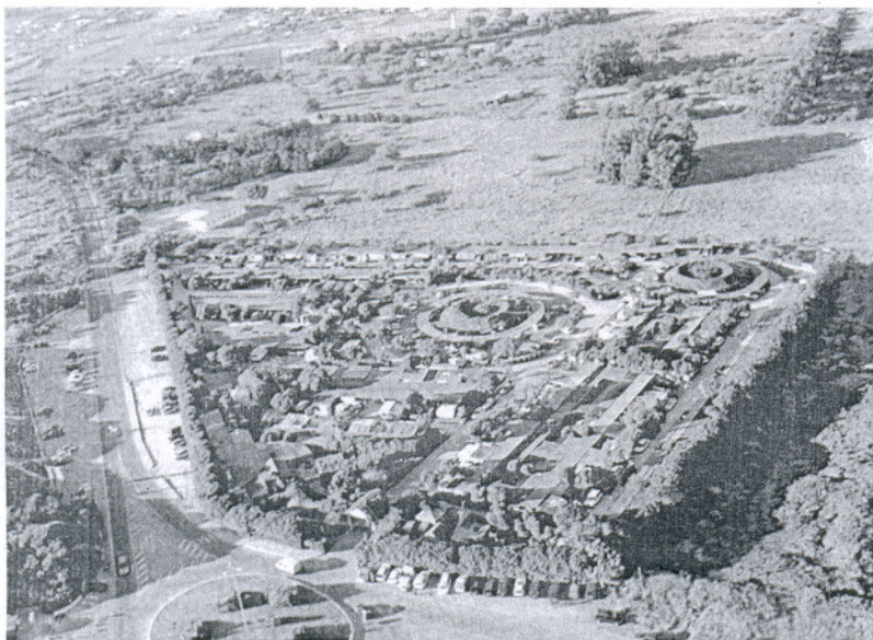
Fotografía aérea del camping de Punta Candor, en Rota, y la zona en la que se construirán varios hoteles.
