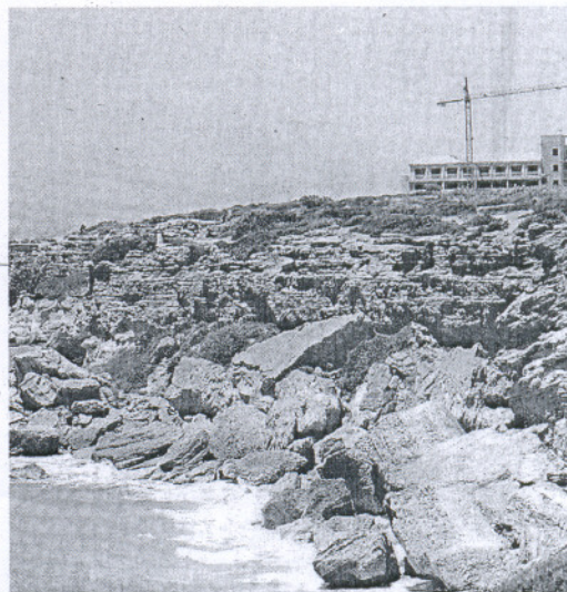
ACANTILADO. Grúas en la costa de Conil. / A. V.
