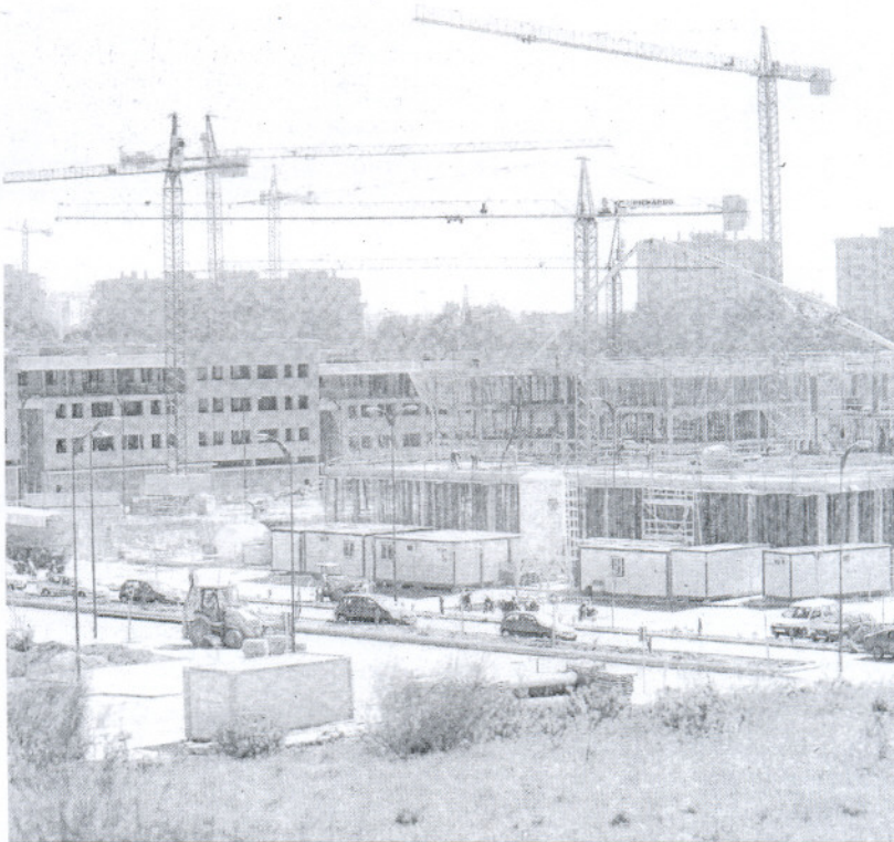
Construcción de viviendas protegidas en Málaga.
