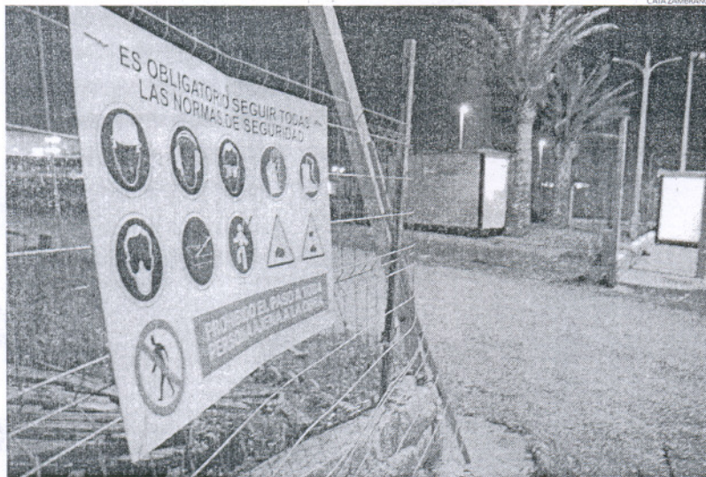
La primera fase de construcción de la nave lleva dos meses de ejecución.
