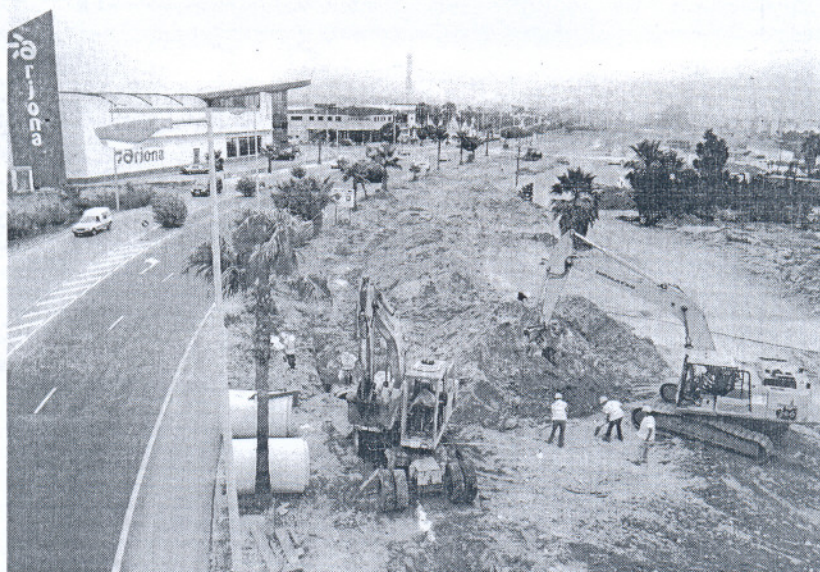
La maquinaria ya trabaja en la urbanización de los terrenos que ubicarán las naves del nuevo polígono.
