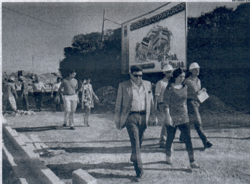
El alcalde, Lorenzo Sánchez, y la primera teniente de alcalde, María Eva Corrales, visitaron las obras del nuevo vial.
