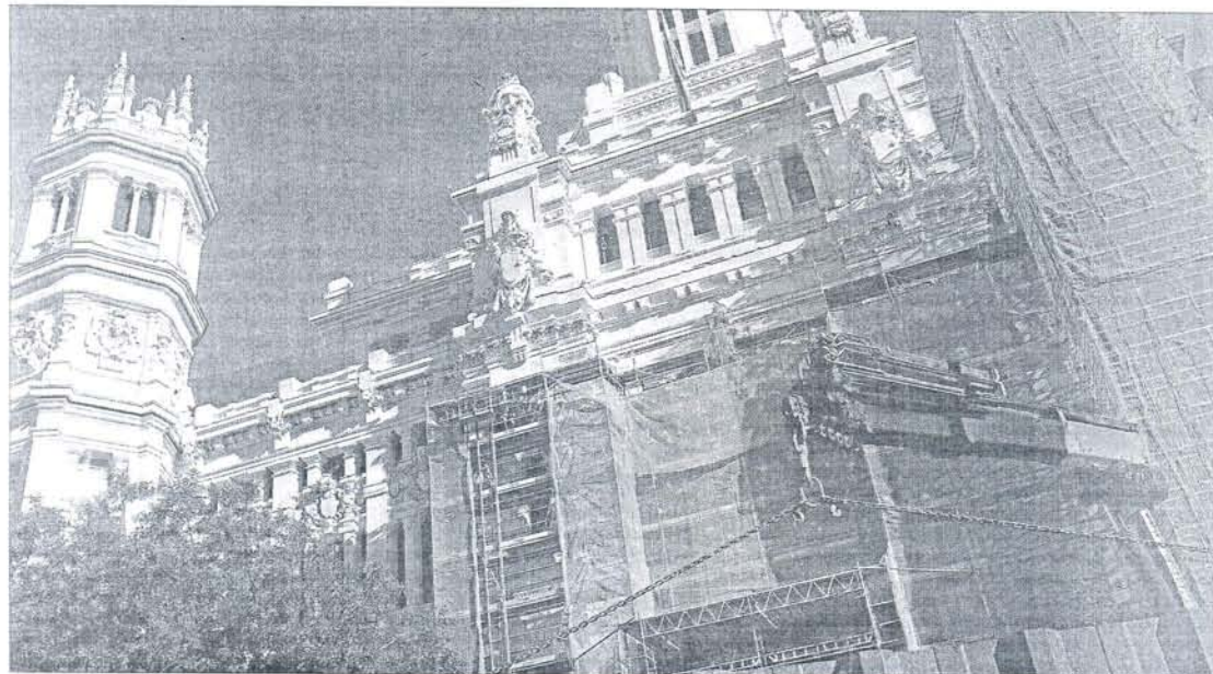
Obras en la fachada del Palacio de Cibeles, antiguo edificio de Correos y nueva sede del Ayuntamiento de Madrid. / ANTONIO HEREDIA
