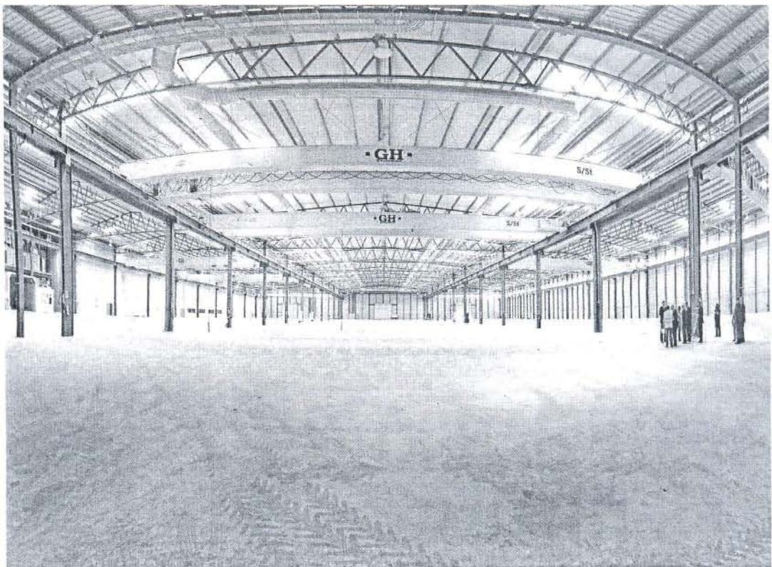
Vista del interior de la nueva factoría de Alestis, ubicada en la zona donde estaba Delphi en Puerto Real.
