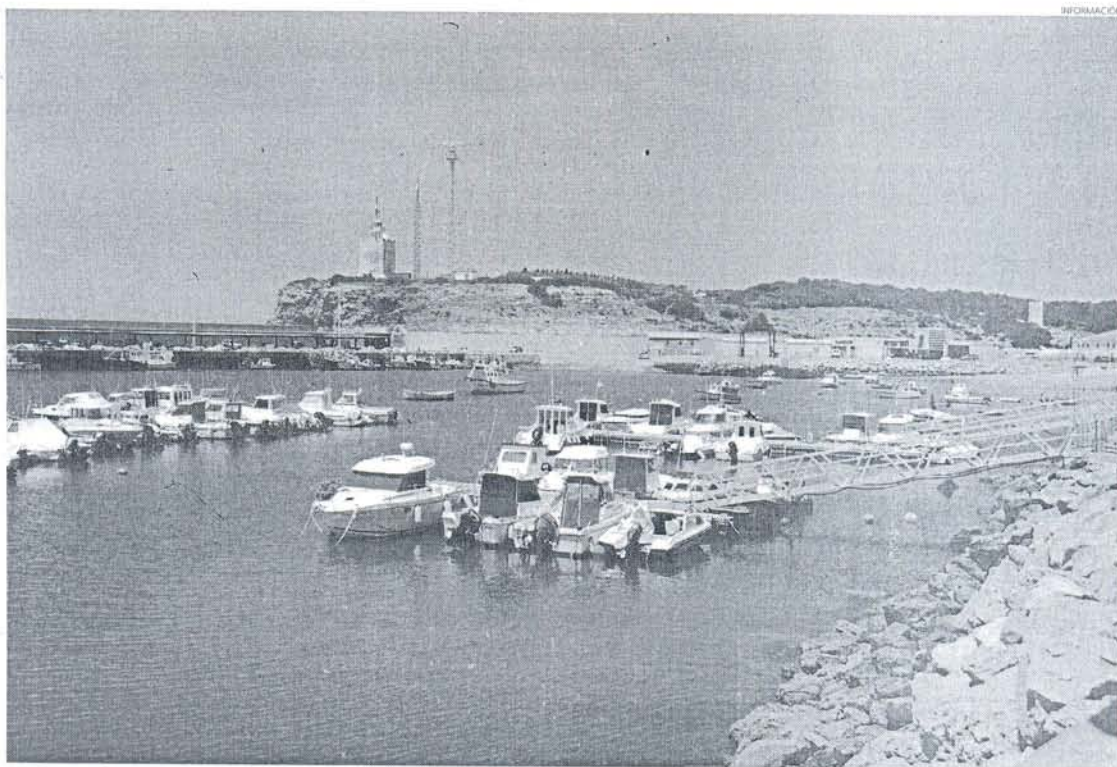
En el Puerto de Conil, Obras Públicas ha destinado una partida de 1,1 millones de euros al dragado de emergencia, una antigua demanda.
